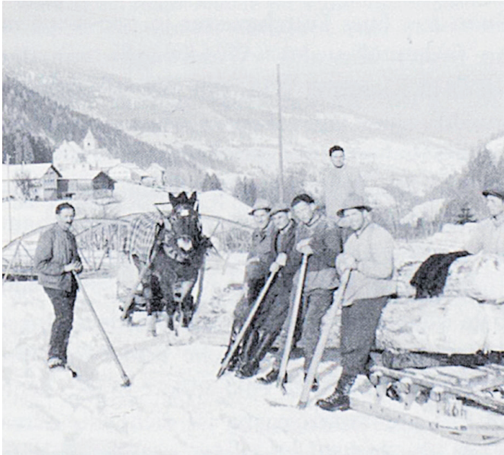
Von Hand wurde das Holz aufgeschichtet und gestapelt.
